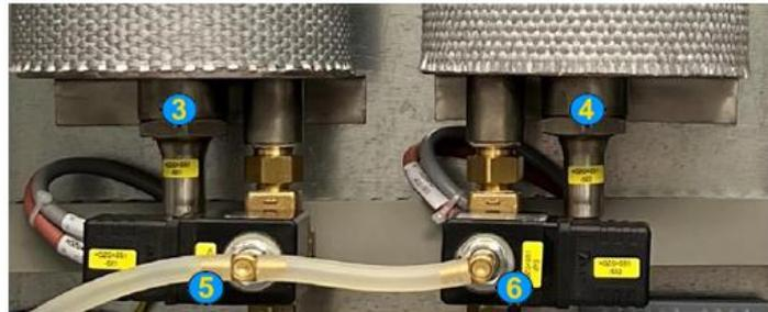
Die Lufttrocknungsanlage besitzt eine Testlauffunktion die mit dem Entfernen der orangenen Steckbrücke auf Klemmleiste X2: Klemme 15 < > 16 gestartet wird. Der Testlauf beschleunigt den 18-stündigen Trocknerzyklus auf ca. 2 Minuten und dient zur Kontrolle oder Diagnose des Lufttrockners. Eine Ozonproduktion ist nicht möglich, hierzu muss die orange Steckbrücke vorhanden und gesteckt sein!
